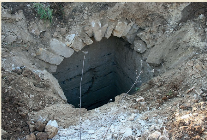
Clé de voûte en moellons bouchant la tête de puits.
