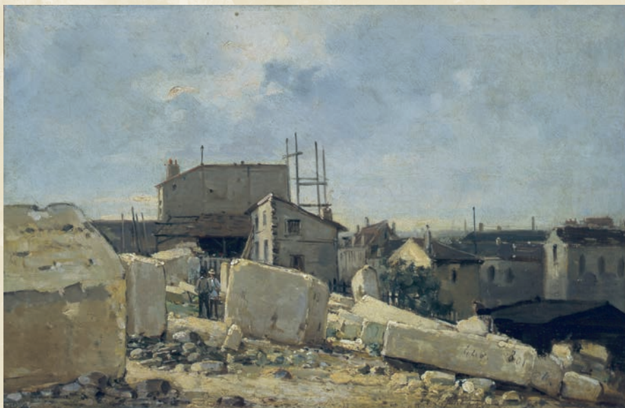
Stanislas Lépine (1835-1892) travaux de terrassement à Caen.
